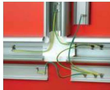
Количество монтируемых проводов заземления в тройнике
