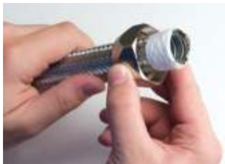
1. Вначале следует надеть на металлорукав зажимную гайку
