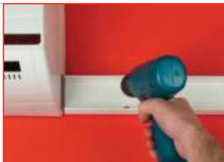
Закрепите основание короба на стене
