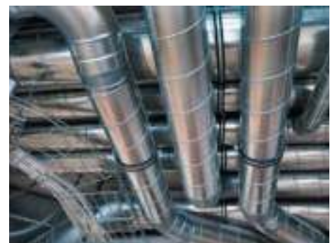
Системы вентиляции, кондиционирования и трубопроводы
