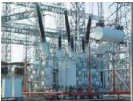
Электрические сети Электростанции, подстанции, линии электропередач
