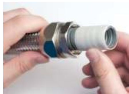
3. При использовании металлорукав в гладкой оболочке – перейти к пункту 4. При использовании герметичного металлорукава необходимо накрутить на край уплотнительную муфту для металлорукав (белого цвета) для получения герметичного соединения. Совет: сдвиньте оплетку от края для удобства монтажа уплотнительной муфты
