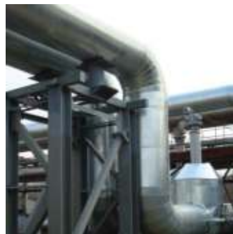
Системы вентиляции, кондиционирования и трубопроводы
