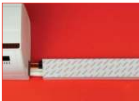
Закройте смонтированную трассу крышкой
