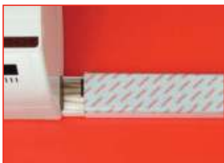
Закройте смонтированную трассу крышкой
