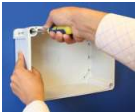
1. Прикрутите корпус к стене
