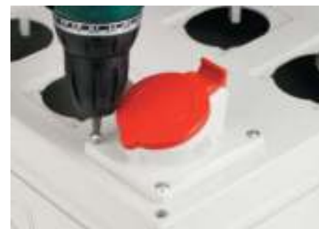
Монтаж розетки на 32 А
