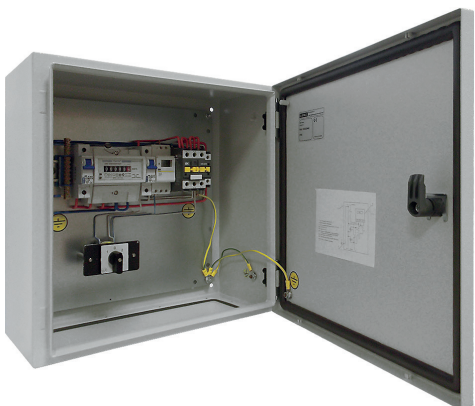
Щит уличного освещения
